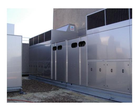
Water flow rate : 10 bis 250 m³/h Kühlleistung : 50 bis 3 000 kW
